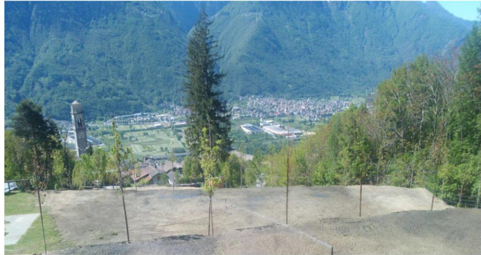
Comune di Cino (SO) Playground area during realization
